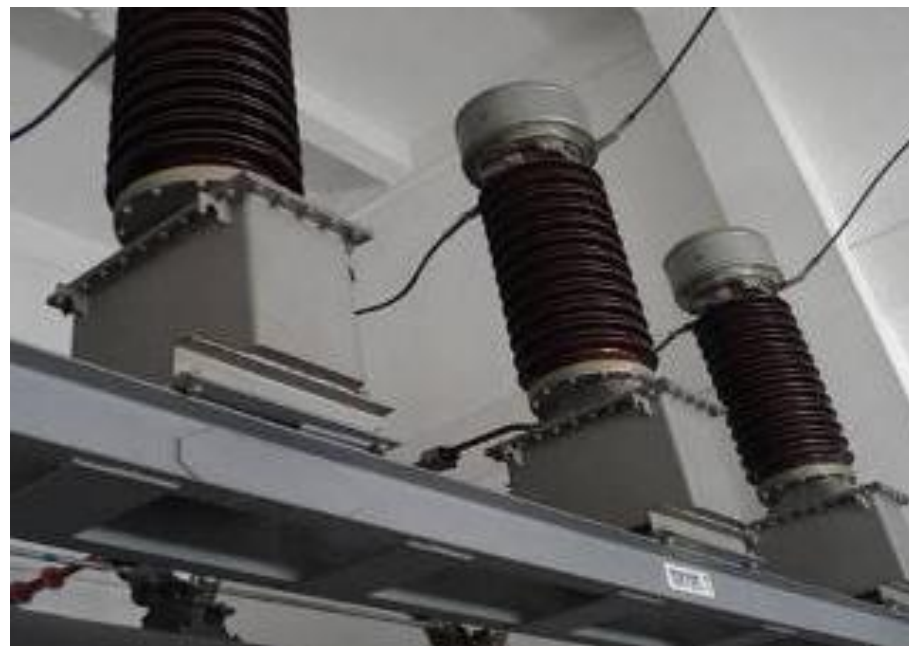
电流互感器将军帽冷却不良
